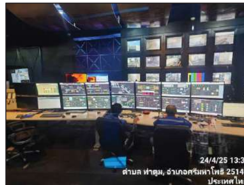
รูปที่ 2-24 ห้องควบคุมการผลิต/พนักงานปฏิบัติงาน ในห้องปรับอากาศ
