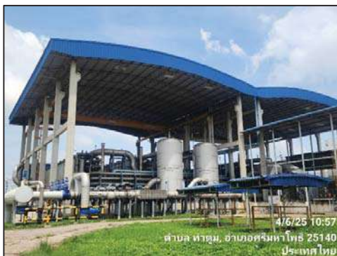
รูปที่ 2-13 ระบบปรับปรุงคุณภาพน้ำใช้
