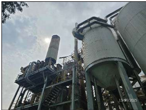
รูปที่ 2-18 ระบบควบคุมมลพิษทางอากาศ (Quench)
